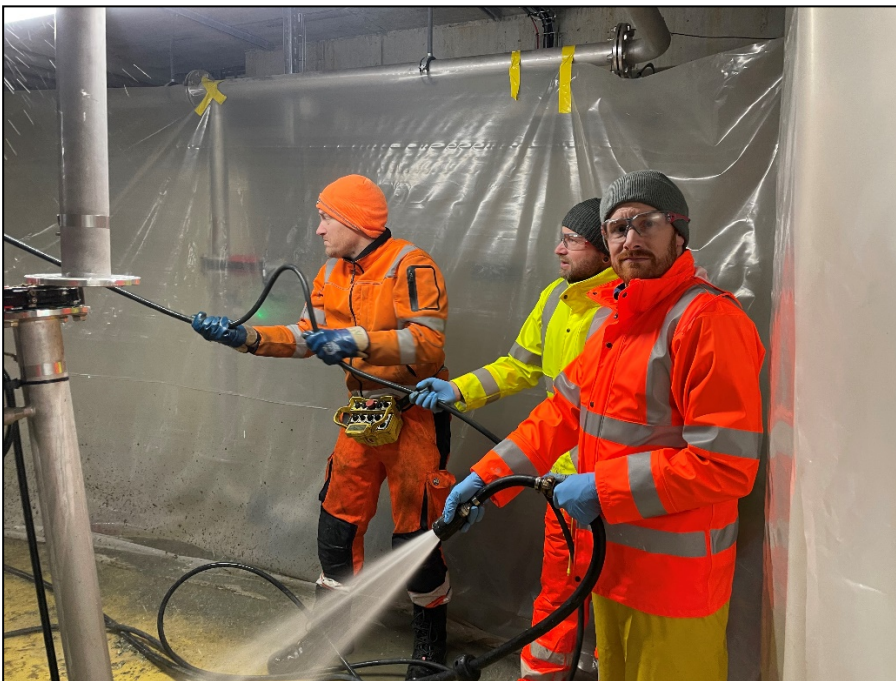
Spülarbeiten an der verfetteten Schlammleitung
