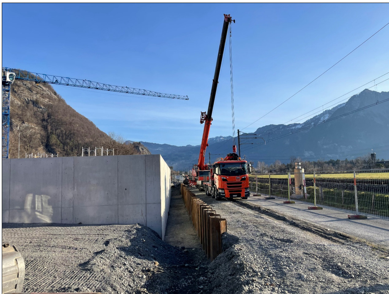
Spundwand entlang dem zweiten Beckenblock wird gezogen.
