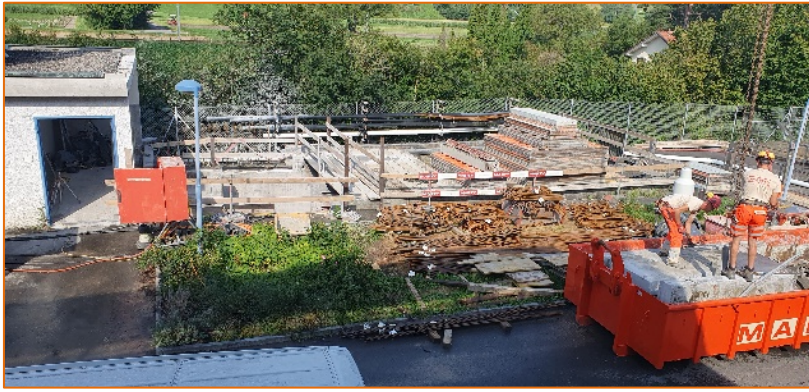
Baustelle Pumpwerk ARA Wartau.
