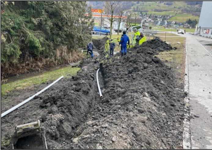
Neue Erschliessungsleitung für die Venturi-Messtechnik Wangs. Aufgrund der ungenauen Lage der Erschliessungsleitung wurden Sondierungen gemacht, welche leider erfolglos blieben. Deshalb wurde die Erschliessung neu ausgeführt.
