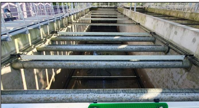
Erste Unterhaltsarbeiten an den Nachklärbecken durchgeführt. Nach der Reinigung wurden die Gleitlager auf Verschleiss und die Ketten auf die korrekte Spannung geprüft.
