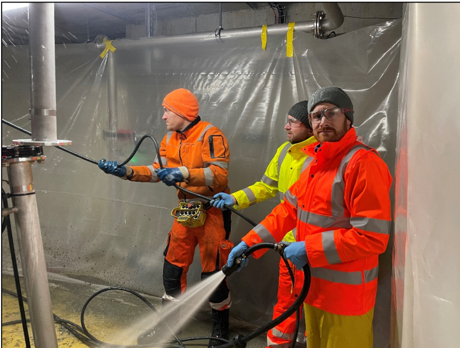
Spülarbeiten an der verfetteten Schlammleitung
