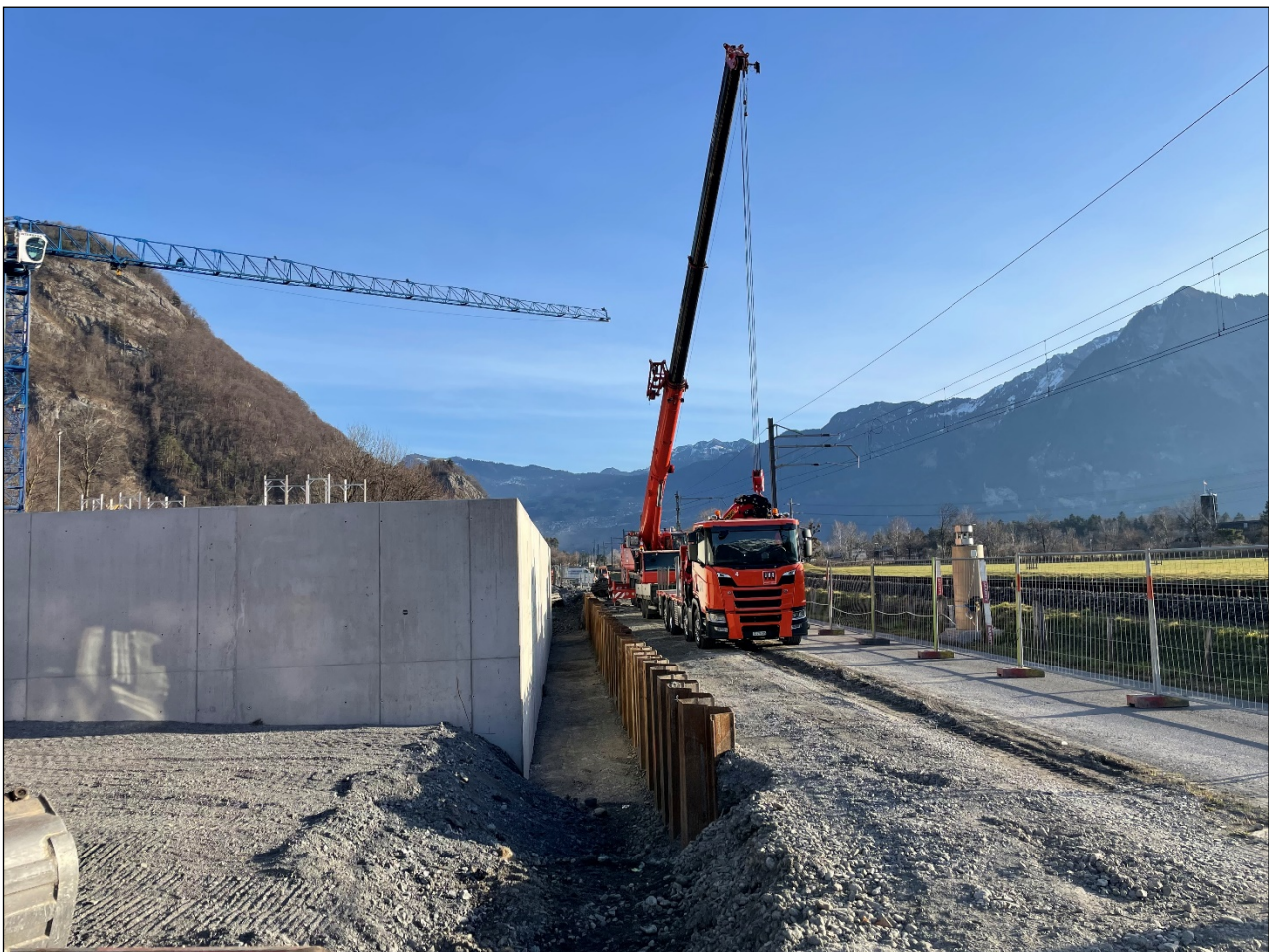
Spundwand entlang dem zweiten Beckenblock wird gezogen.
